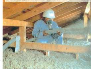
天井の上に 施工密度 25±3 kg/m 3 で厚み160mmをフローイング
