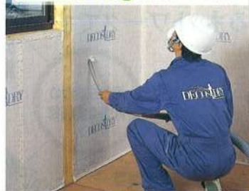
壁は柱の厚みいっぱい 施工密度 55±5 kg/m 3 でフローイング
