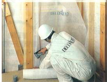
マスクと同じ材質の通気するシートを弛みなく張る
